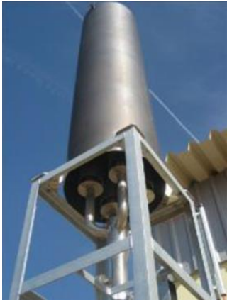
Ilustración 32 – Antorcha de biogás.
