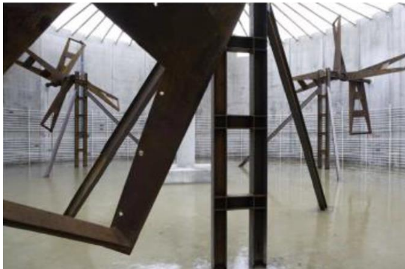
Ilustración 19 – Ejemplo del sistema de mezcla interior de un digestor anaerobio.
